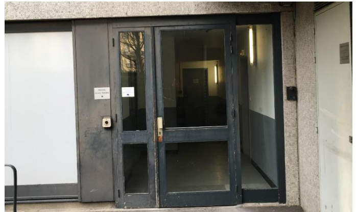
Portes d'accès au sous-sol
