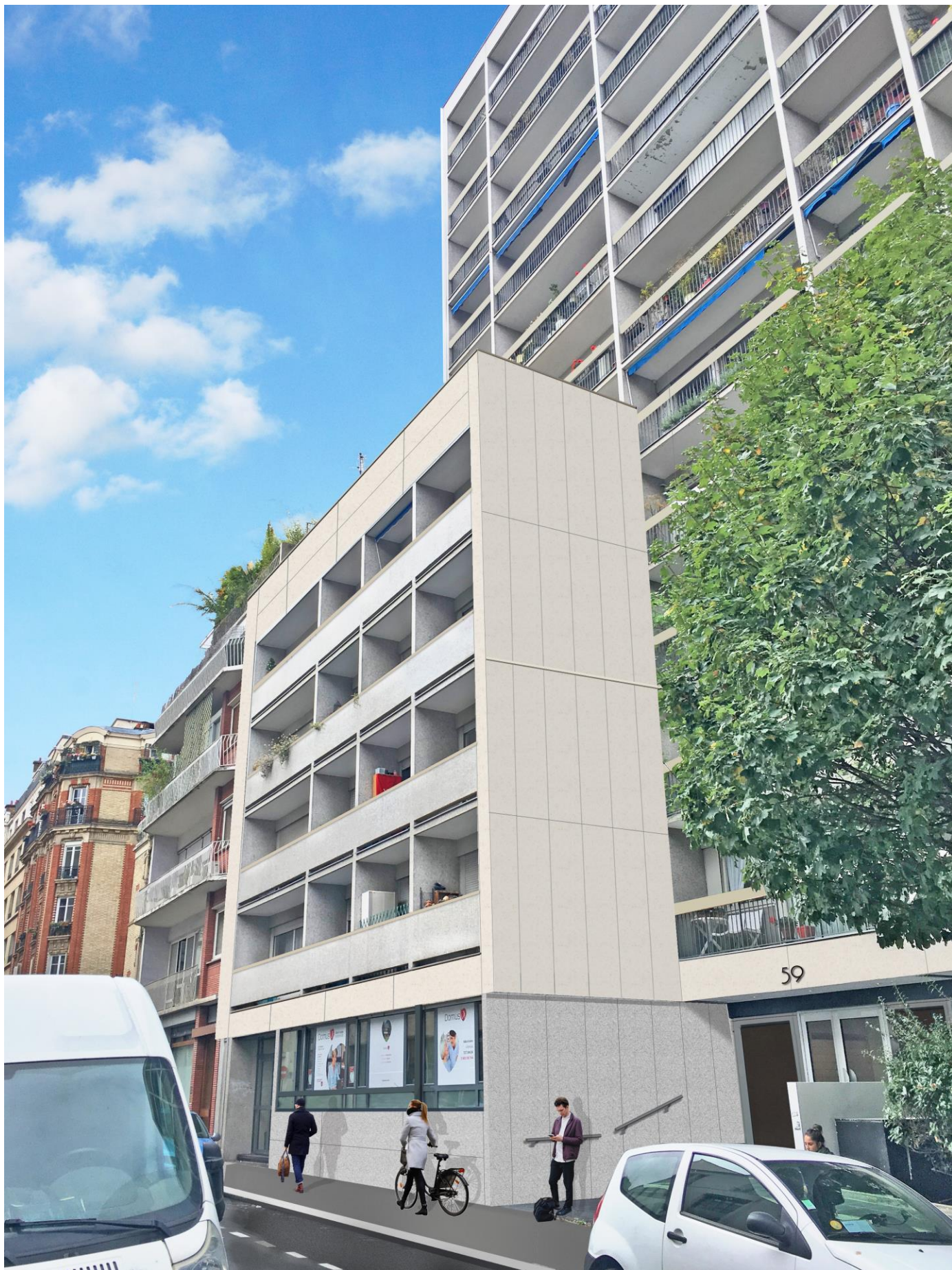
Bâtiment A – 59 rue Eugène Carrière
