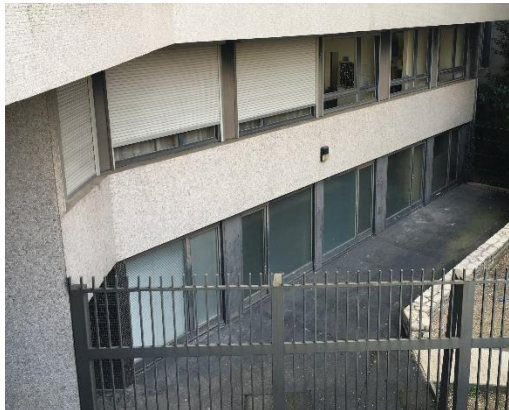
Portes-fenêtres du local du conseil syndical Porte d'accès au sous-sol
