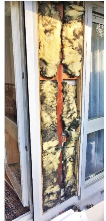
Un trumeau entre deux chambres avec la plaque de bois déposée.
