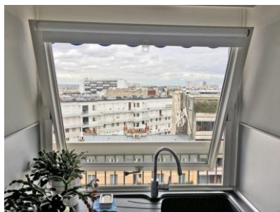
Etat existant : une fenêtre en pivotant-basculant
