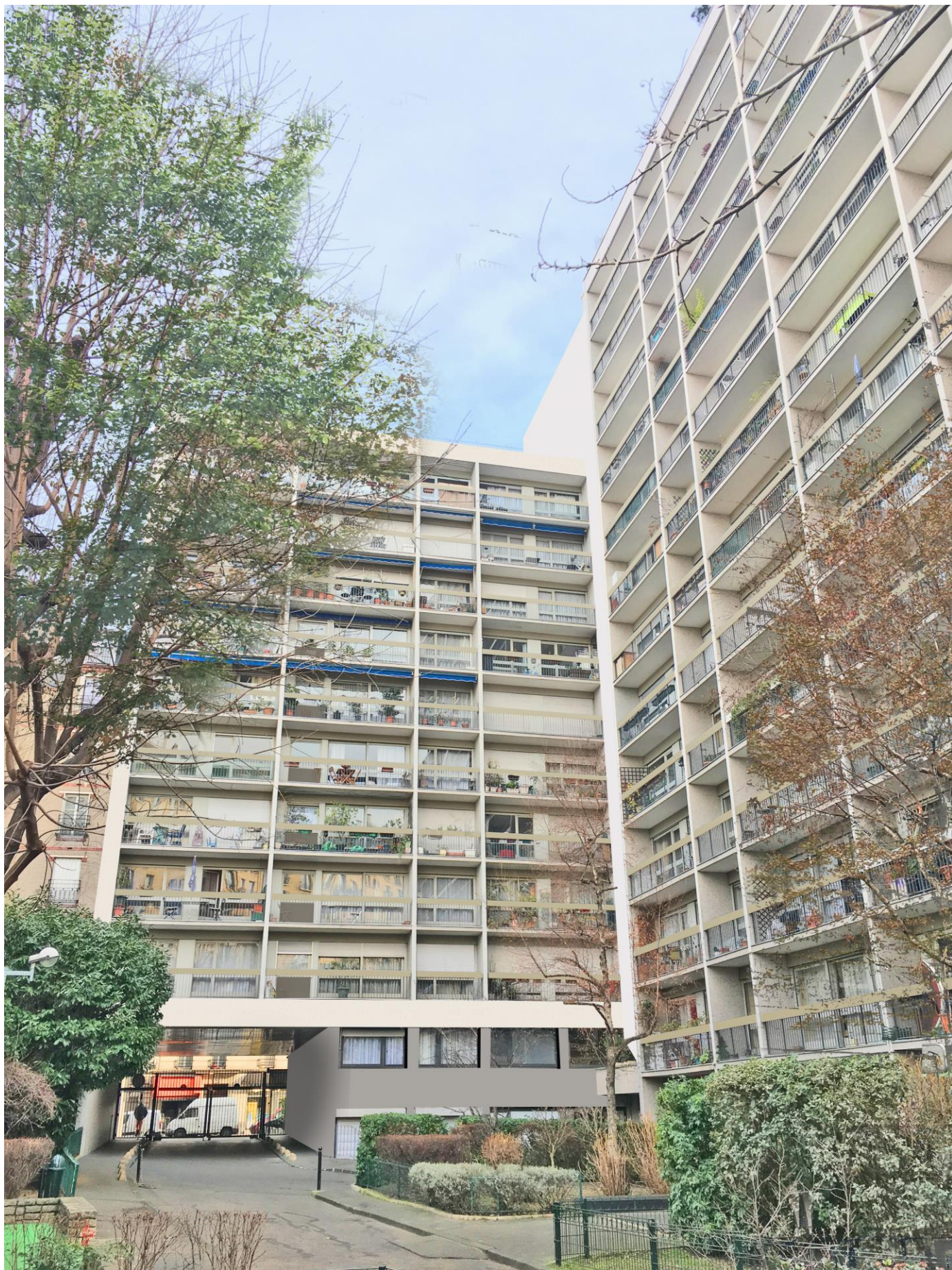
Bâtiment A depuis la rue intérieure
