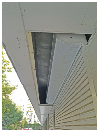
Vue dans l'élément préfabriqué sans la cassette
