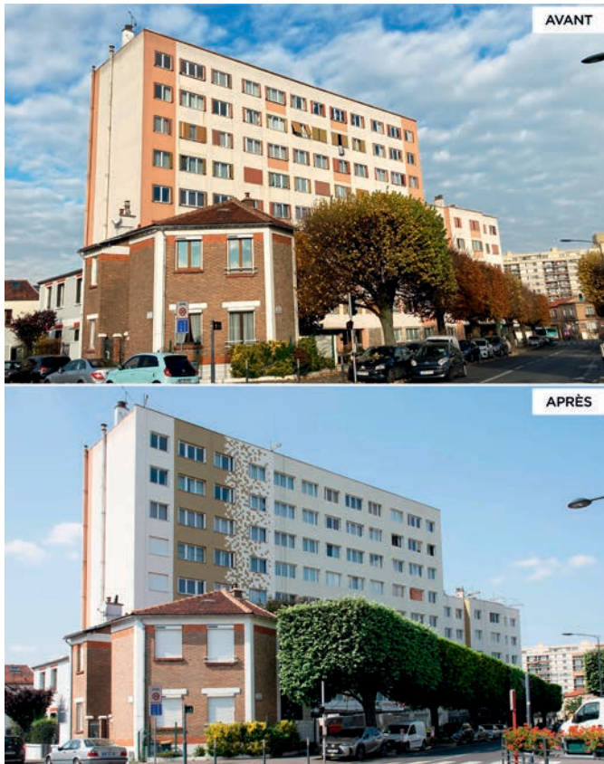
Rénovation globale de la résidence Marcel-Martinie (Vanves) réalisée par Reanova, en cours de travaux (2021).
